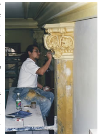
Restauración de columnas
