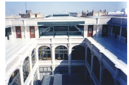
Niveles superiores restaurados
