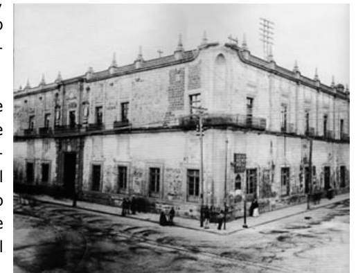
Antiguo Hospital de Terceros
