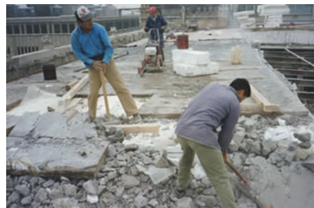
Reparación en azotea
