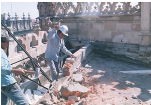
Demolición de construcción agregada
