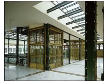
Cuarto nivel concluido
