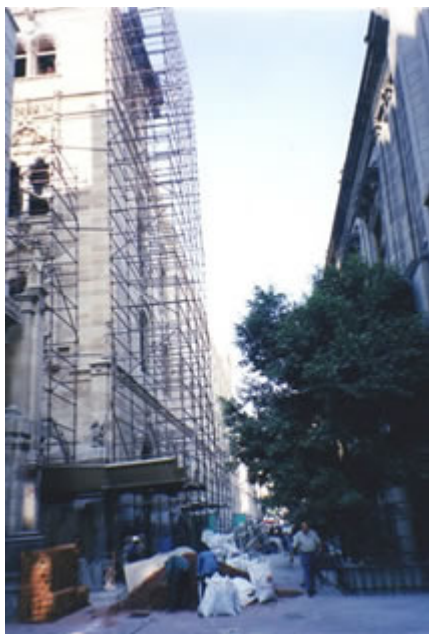
Restauración de exteriores
