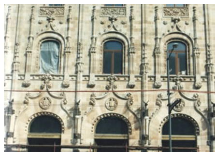
Restauración de fachadas
