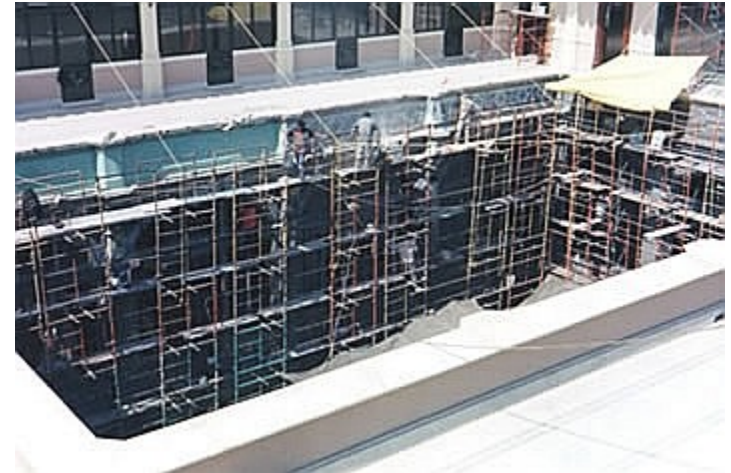
Trabajos en el interior del Palacio
